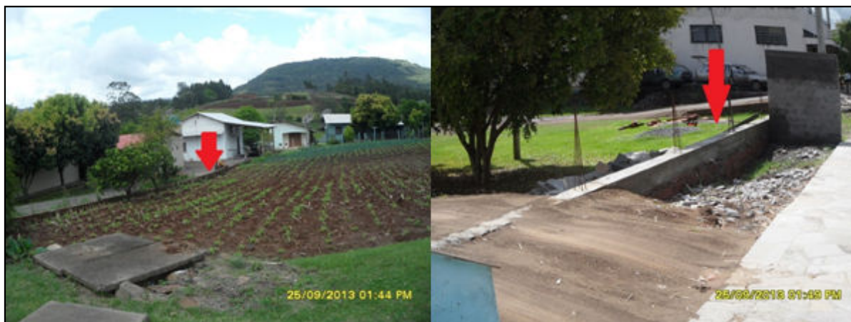
Figura 15: Localização de galerias (seta vermelha) próximas às edificações.
