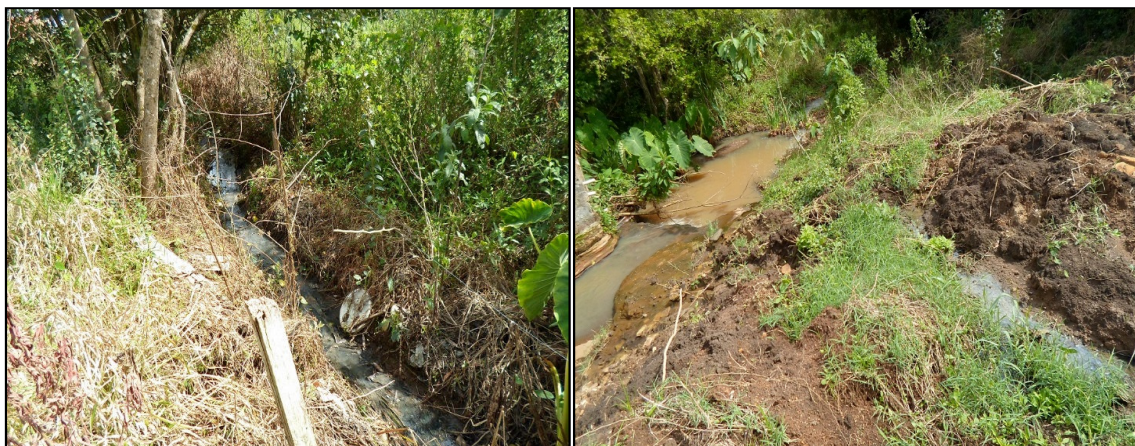
Figura 23: Vista da vala de esgoto a céu aberto e sua saída, próximo a um córrego.
