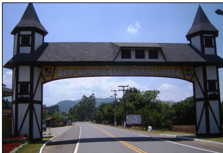
Figura 17: Asfalto, o principal tipo de pavimentação do município.
